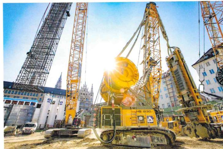
Der Raupenkran LR 1250 positioniert die Armierungskörbe.
